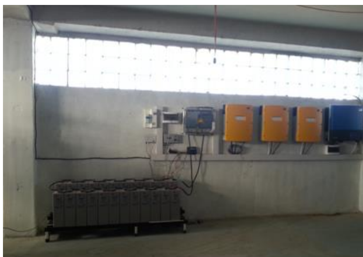
18.2- rasm. 20 kVt quvvatli FES energetik boshqaruv bloki va nazorat qurilmalari
