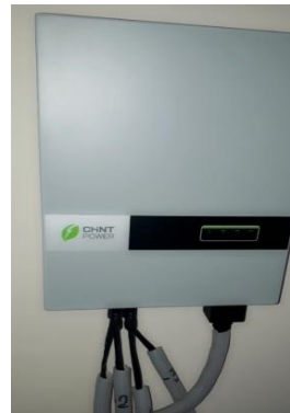
Рис.1. А) Общий вид солнечной фотоэлектрической станции мощностью 10 кВт, соединённой с низковольтной сетью Энергетического факультета Б) Сетевой инвертор, электросчётчик и автомат переключения
