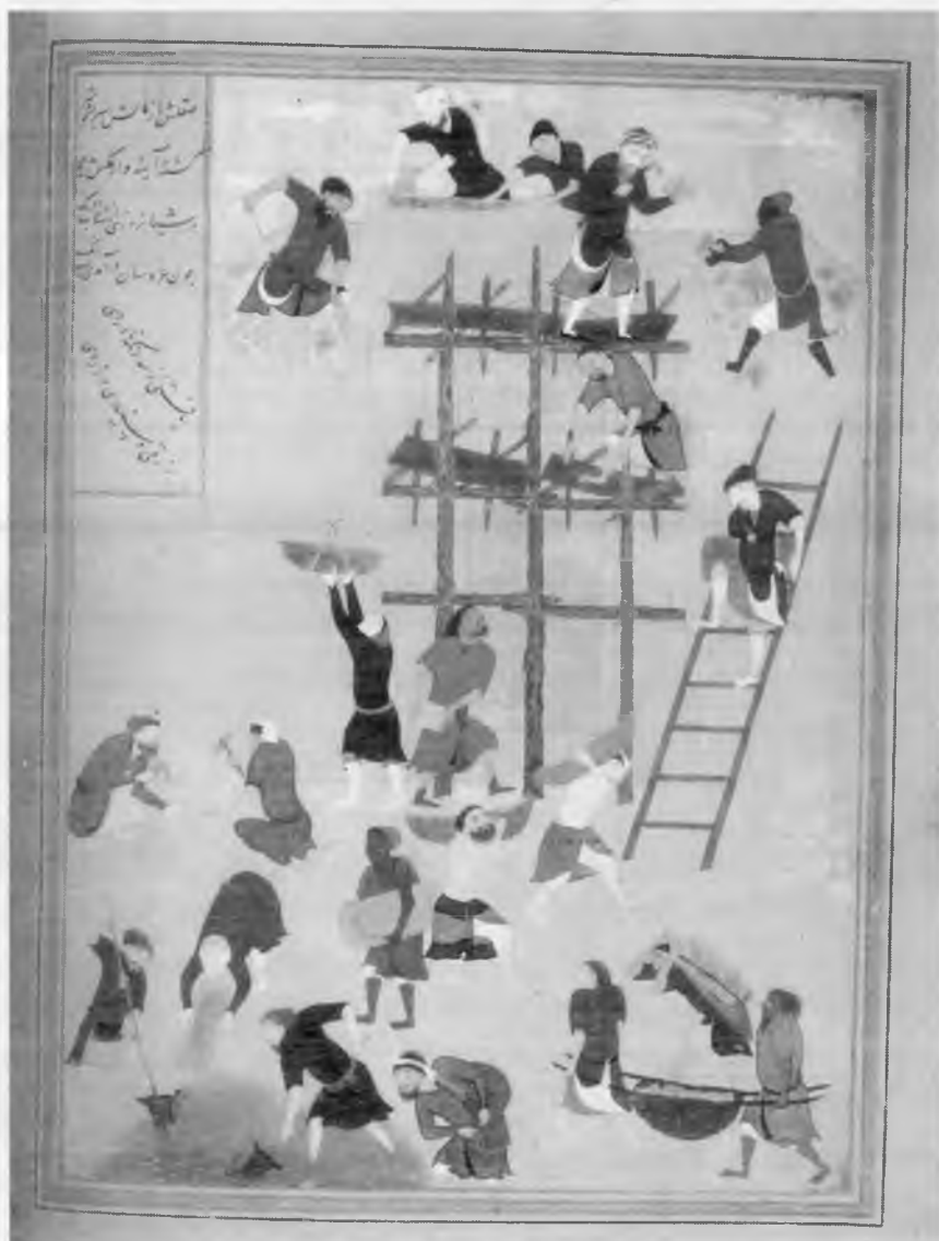
Строительство дворца в Хаварнаке. Миниатюра из "Хамса" Низами. 1494-1495 г.
