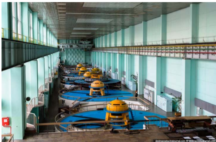
7.5- расм. ГЭС нин машина зали ва гидротрубинаси.
