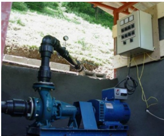
7.11-расм. Горизонтал жойлашган генераторлар.
