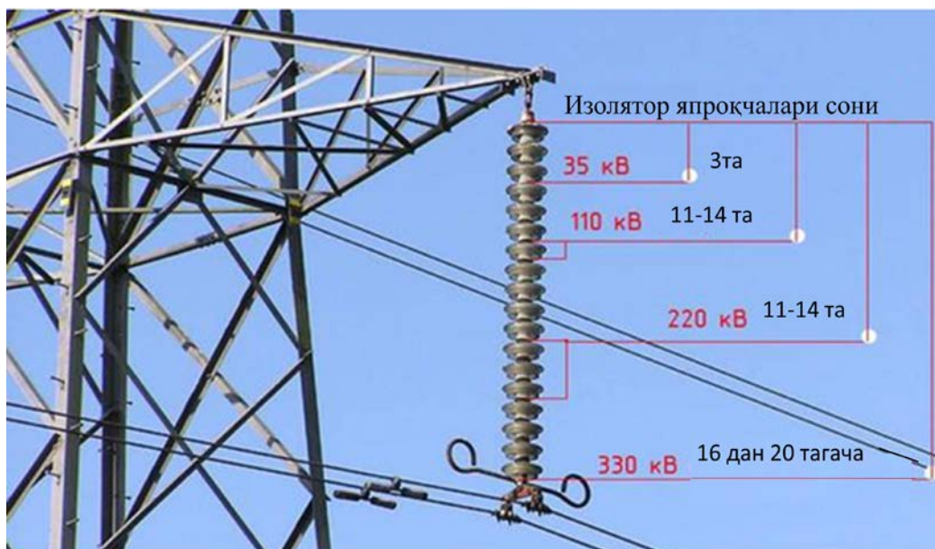
7.23-расм. Гирлянд изоляторлар.
