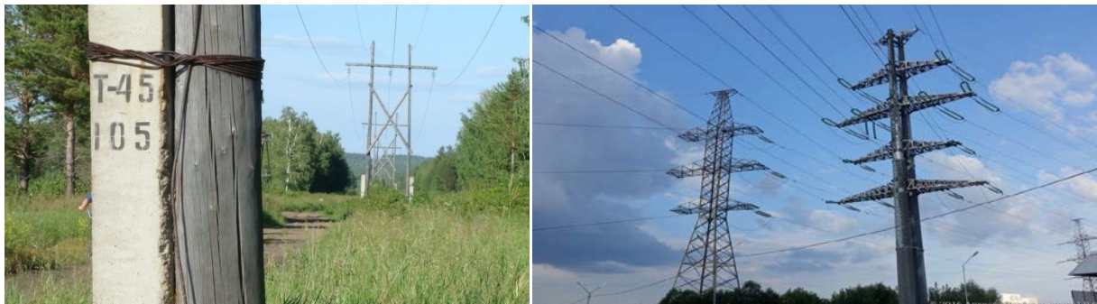
а б 7.18-расм. Ёғоч таянч, темир-бетон ва темир конструкцияли таянчлар.
