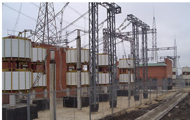
2.23-расм. Алоҳида хонадонлар учун ва тақсимлаш станцияларининг реактив қувват компенсаторлари
