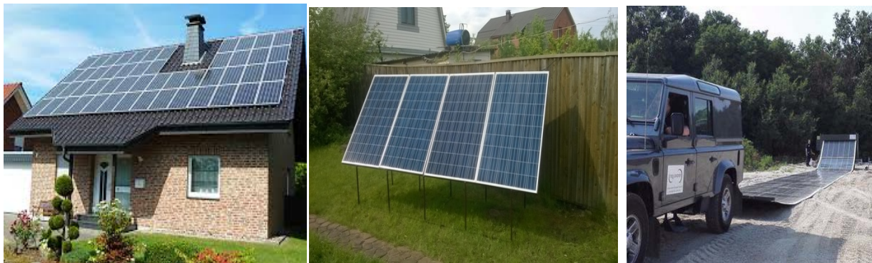
7.36- расм. Қуёш панелларининг том варианты (а), каркас варианты (б) ва 11 кВт қувватли юпка плёнка варианты.
