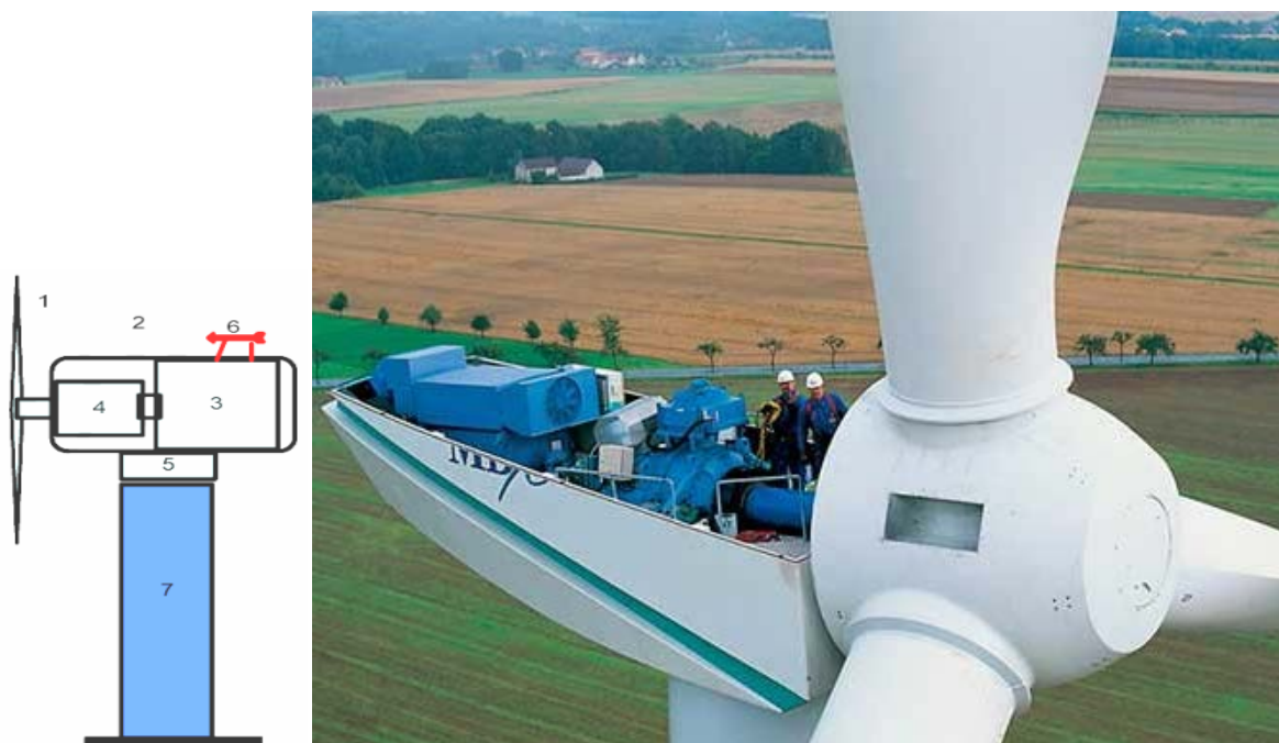
7.47- расм. Шамол электр қурилмасининг тузилиши ва умумий кўриниши. 1-шамол парраги, 2-бош қисм (головка), 3-электр генератори, 4-редуктор, 5-айланувчи платформа, 6-ўлчов қурилмалари блоки, 7-қурилманинг устуни.
