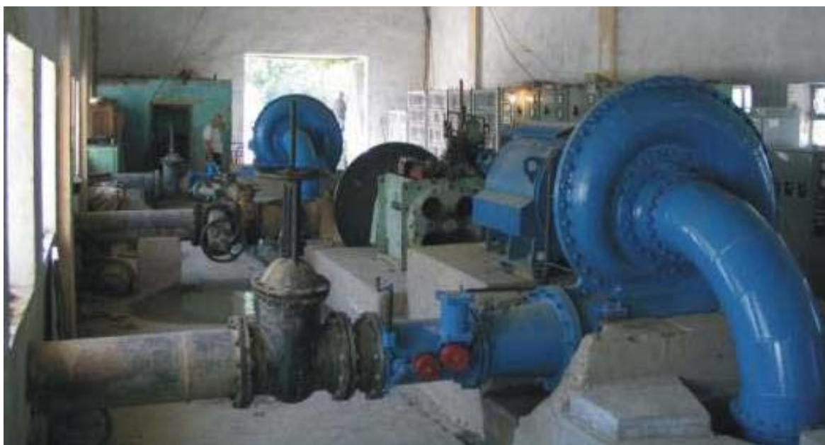
3.11-rasm. Gorizontol radial-o'qiy turbinalar o'rnatilgan kichik GES binosining ko'rinishi.
