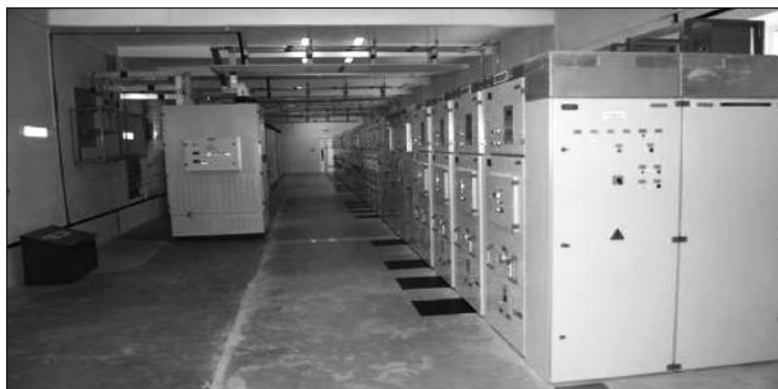
Рис. 5.35. Машинный зал РУ-3,3 кВ
