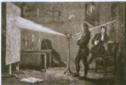
▲ Эксперимент с призмой. Поскольку угол исходящего из отверстия света ежесекундно меняется, Ньютону приходилось постоянно регулировать положение призмы и отражающего экрана.
