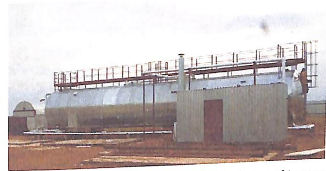
4.8-rasm. Biyg'itish rezervuari gorizontalkonstruksiya biogaz qurilmasi
