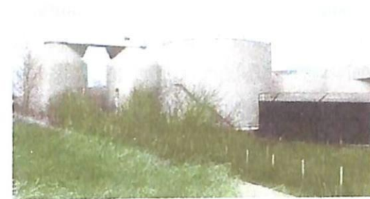
1.3-rasm. Kommunal biogaz qurilmasi (tozalash inshootidagi anaerob bosqich)
