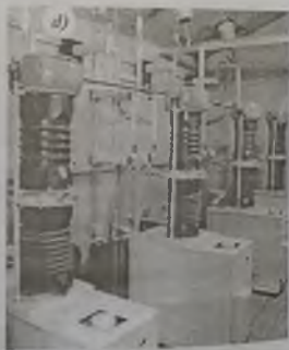
132-rasm. Seksiyalash va parallel ulash postlari: a – PSK-27,5-1 qurilmasining tashqi ko‘rinishi; b – yuqori kuchlanishli bo‘limi; d – parallel ulash postlari PSK-27,5-2 qurilmasining yuqori kuchlanishli bo‘limi.
